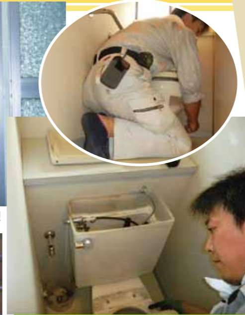
工事部位ではない所でも修理した方がよいと思われる事は伝えます。(簡単な事なら即無料で補修)
